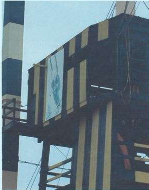
ภาพหอสูงก่อนติดตั้งงานนวัตกรรม
